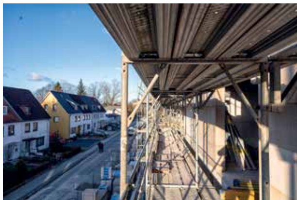
Blick auf das vor der Baustelle gelagerte Material
