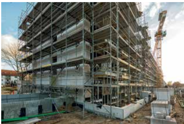
Die Rude-Baustelle im Januar 2019
