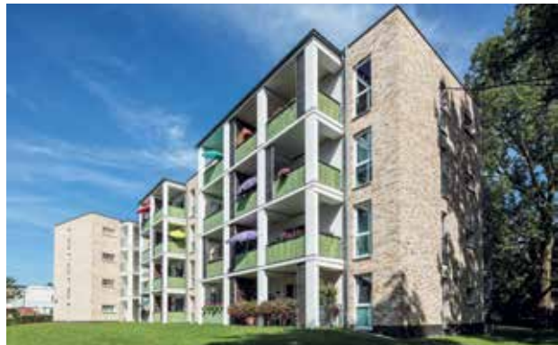
Wohnanlage im Marrensdamm
